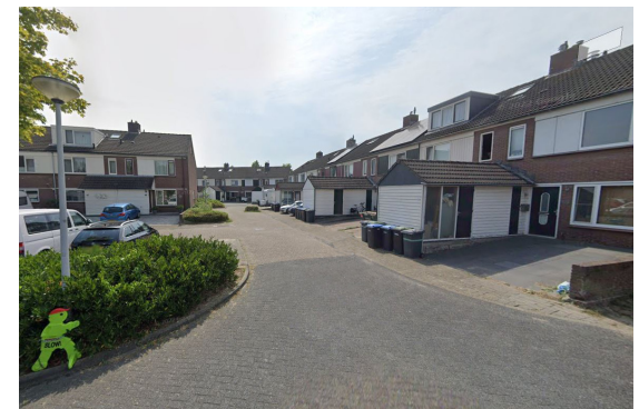
Woningbouw in Molenvliet
