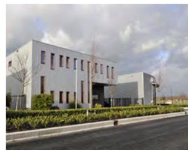
Gevels Nieuwland Parc zijn representatief en eenvoudig gedetailleerd
