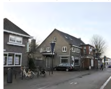
In het dijklint is sprake van enige functiemenging
