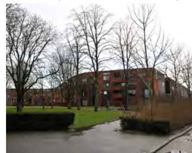
Appartementengebouwen hebben diverse vormen en variëren in hoogte
